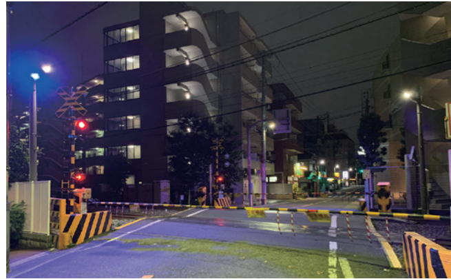
踏切青色照明
