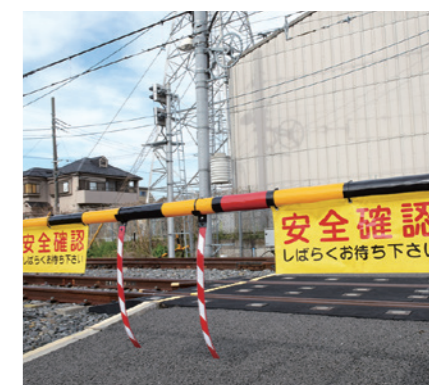
遮断かんさげベルト・遮断かん警告標
